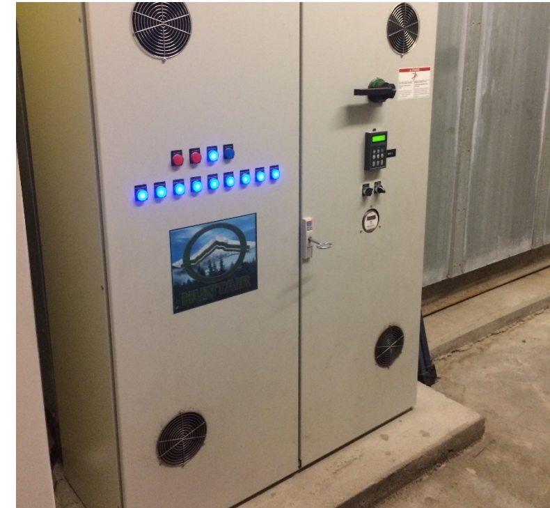
Club AHU Supply Fan Array VFD
