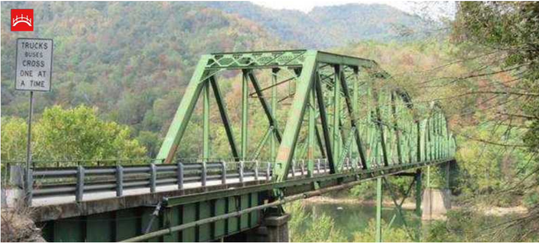
Kanawha Falls Bridge
