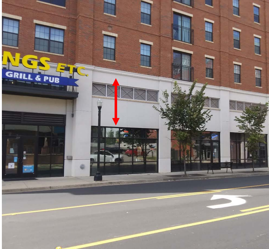
~12' spandrel NONCOMPLIANT
