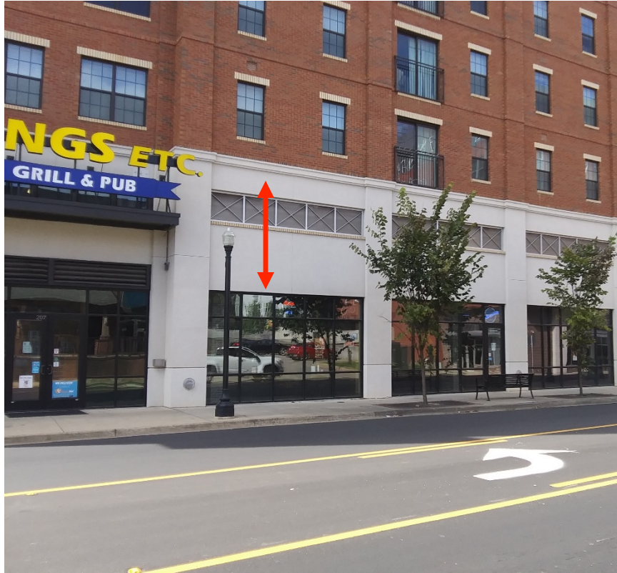
~12' spandrel NONCOMPLIANT
